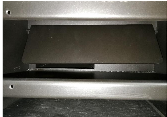
Bild 2: Überprüfen Sie die korrekte Position der Rauchleitplatte.
