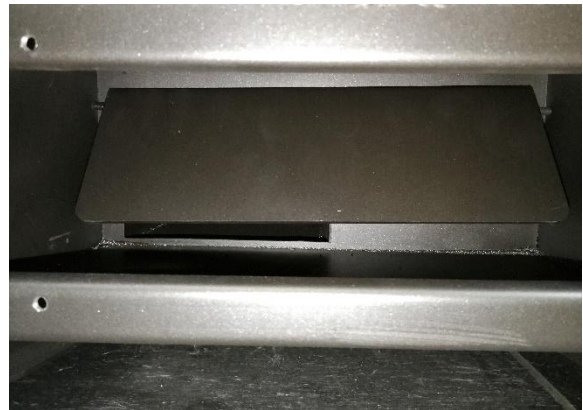
Bild 2: Überprüfen Sie die korrekte Position der Rauchleitplatte.
